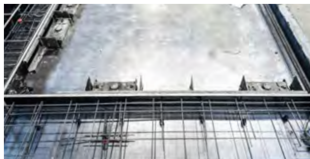
Évidement avec MST et angle de fenêtre en bois
