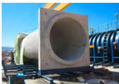
Élément de tuyau pompé avec UPP
