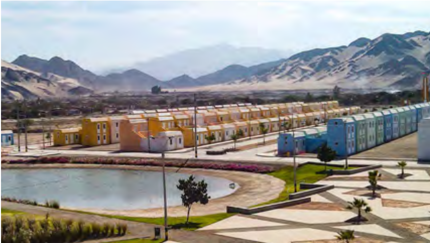
Logement modulaire, Peru
