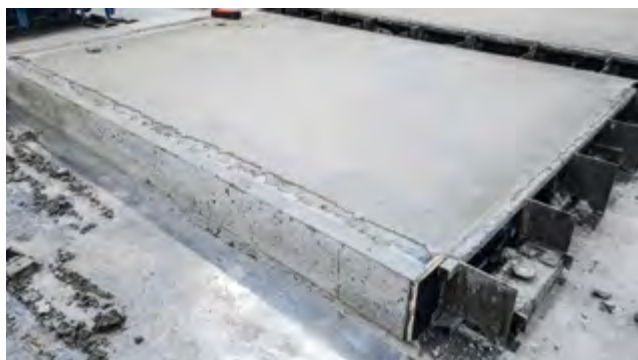
Évidement avec MST et angle de fenêtre en bois
