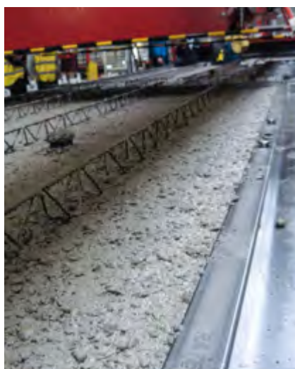
Production de dalles filigranes
