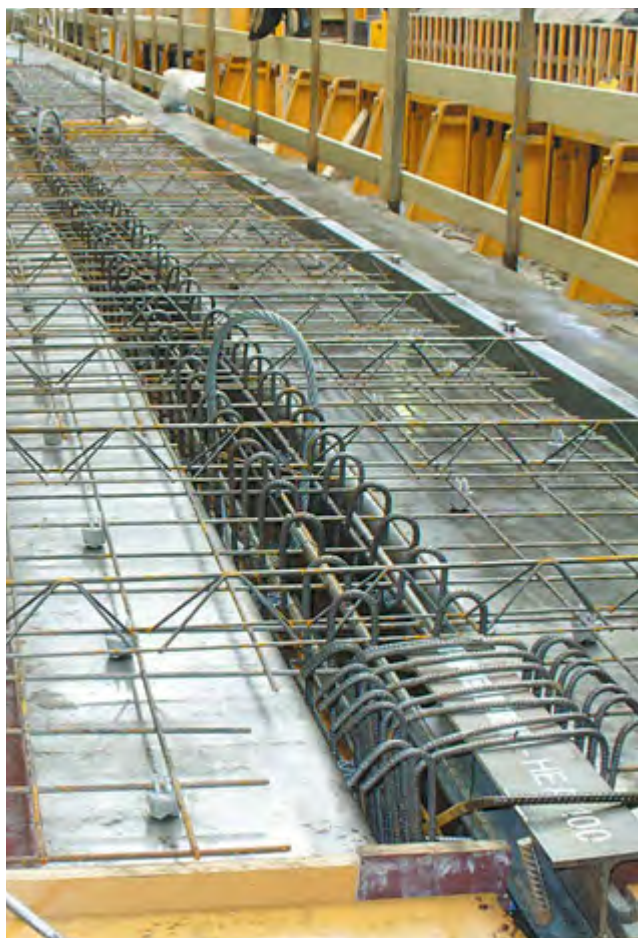
Production de plafonds TT
