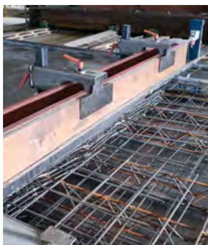
MST selon le processus de bétonnage
