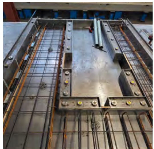
SAS-Aussparungslösung – durch den Roboter gesetzte Absteller werden manuell mit maßgefertigtem Schalholz ergänzt
