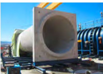
Rohrelement gepumpt mit UPP
