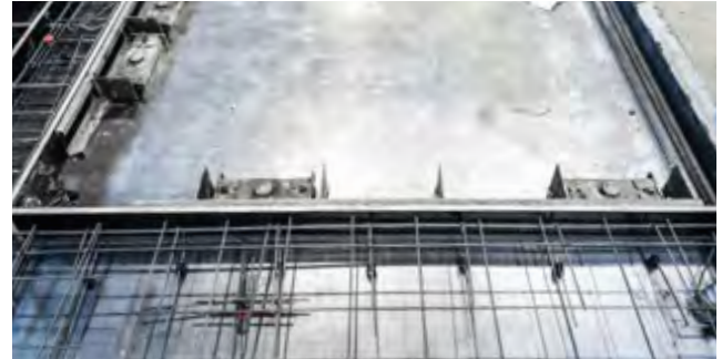
Aussparung mit MST und Holz-Fensterstecke
