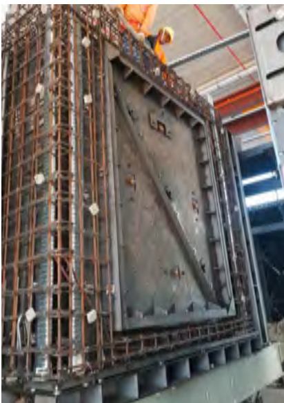
Schrumpfbare Fensterschalung
