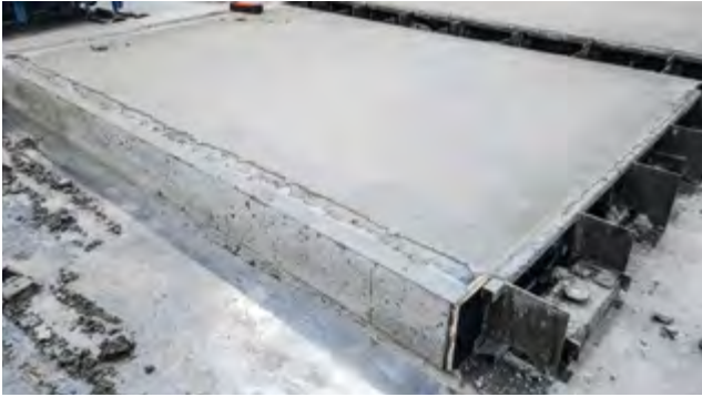
Aussparung mit MST und Holz-Fensterstecke
