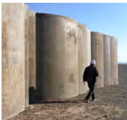
Mastelemente für Windfarm, China
