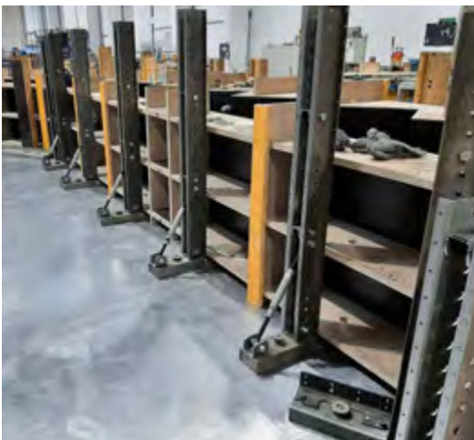
Easy Form mit Vertikalstützen kann für die Herstellung von stabförmigen Elementen oder z.B. Treppen verwendet werden
